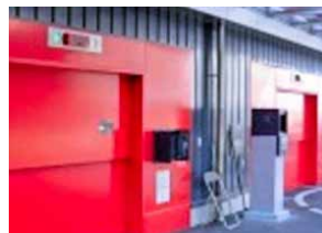
立体駐車場開閉扉
