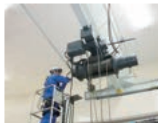
クレーン点検
